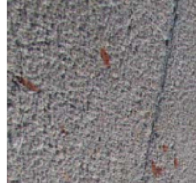
Galerie extérieur : Dallage béton inclusion de briques finition sablé
