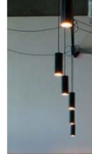
Luminaires suspendus au dessus du bar
